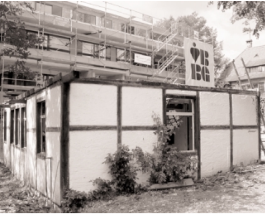
Das sich im Rückbau befindende Schopfgebäude an der Bahnhofstrasse 50A, im Hintergrund der BBG-Neubau Bahnhofstrasse 50. Foto: Rolf Spriessler
