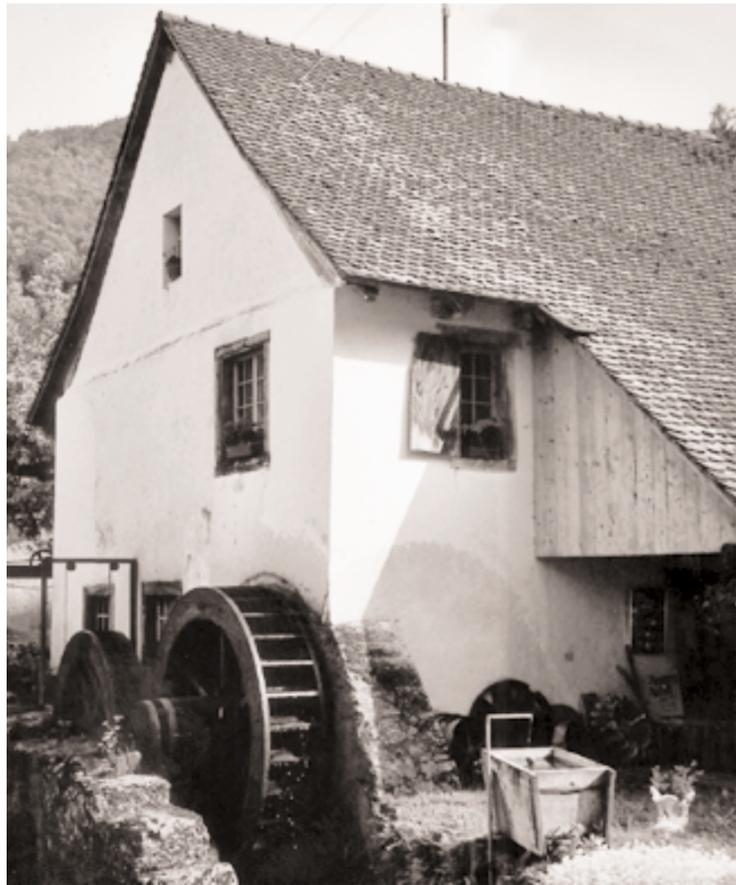
Die Schmitte in Beinwil ist eine der letzten funktionierenden Hammerschmieden der Schweiz. Das hölzerne, von der Lüssel angetriebene Wasserrad dreht eine massive Eichenwelle. Deren grösserer Teil trägt einen Nockenring und ragt ins Innere des Gebäudes. Wird die Welle durch Wasserkraft angetrieben, ...
