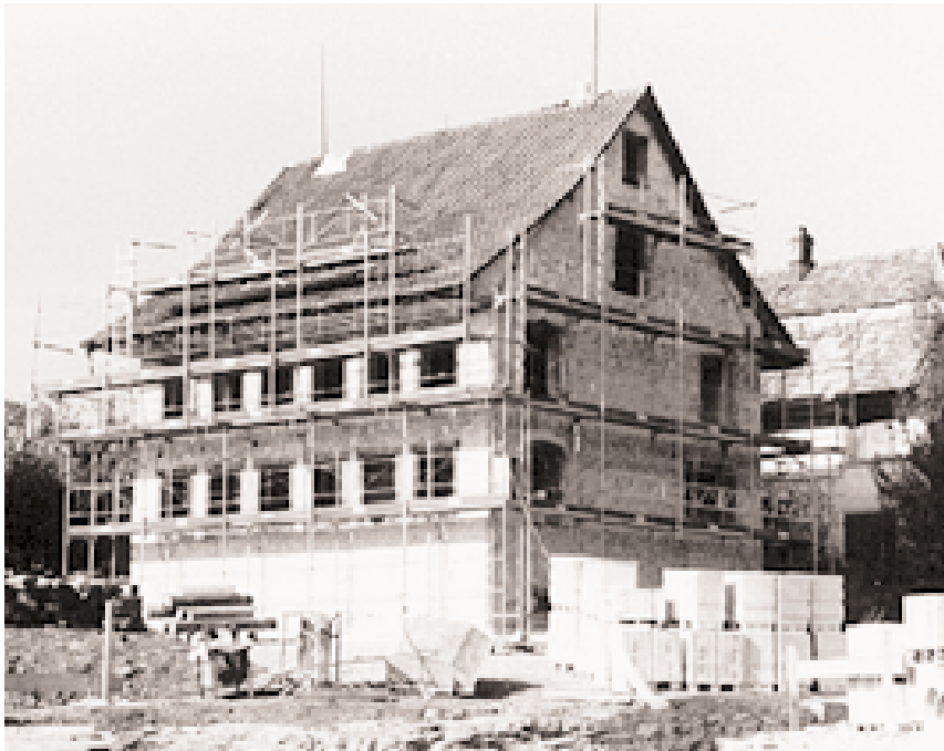
Wie man bei der Sanierung und Renovation seiner Liegenschaft böse Überraschungen vermeiden kann, erfährt man beim Besuch des Renovationsseminars der Basler Kantonalbank.
