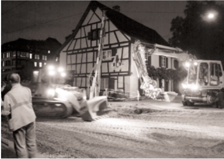
Zur temporären nächtlichen Grossbaustelle wurde vor Wochenfrist der Bahnübergang an der Schmiedgasse. Grund für die spektakuläre Aktion war der Einbau einer neuen Weiche auf der Wiesentalbahnstrecke.
