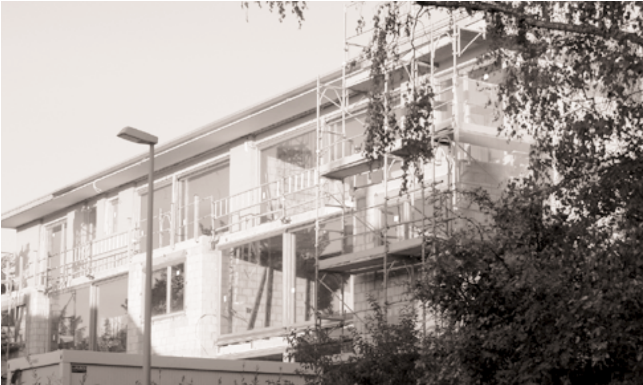
Bei dem vom Riehener Architekten Matthias Buser geplanten Mehrfamilienhaus an der Niederholzstrasse 43 konnte letzte Woche die Aufrichte gefeiert werden. Das Projekt war wegen einer Einsprache während eines Jahres blockiert. Diese Zeit wurde dazu benutzt, das Projekt auf «Minergie»-Standard zu bringen. So wurde unter anderem eine kontrollierte Komfortlüftung mit Wärmerückgewinnung eingeplant und die Fassadendämmung von den üblichen 12 Zentimetern Dicke auf bis zu 20 Zentimeter verstärkt. Darüber hinaus wird das Gebrauchswasser mit den auf dem Dach installierten und genau nach Süden ausgerichteten Sonnenkollektoren vorgewärmt. Fünf der sieben Eigentumswohnungen waren bei Baubeginn bereits verkauft, die verbliebenen zwei werden vorerst noch vermietet.
