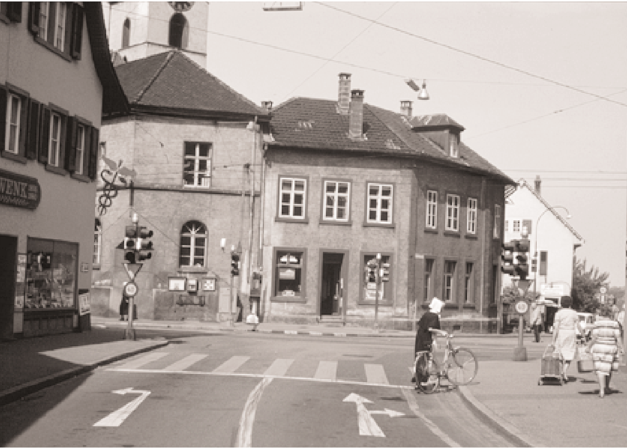
Das heutige «Haus der Vereine» 1980 vor dem Umbau, von der Schmiedgasse aus gesehen. Links oben sieht man den Turm der Dorfkirche, rechts hinten das Erlensträsschen. Fotos: zVg IG Haus der Vereine aus der Tonbildschau des Architekten Hans Roduner
