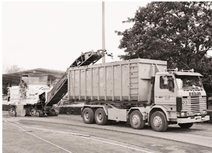
Eine Spezialmaschine fräst den Kunststoff vom Schwarzbelag und befördert ihn direkt in den vorne mitfahrenden Lastwagen.
