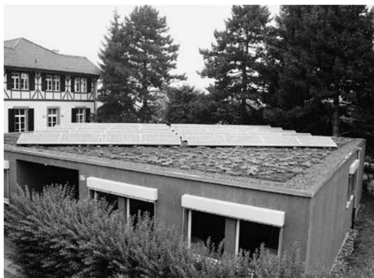
Die Photovoltaik-Anlage auf dem Pavillondach der Klinik «Sonnenhalde» (Bild) soll jährlich 4000 Kilowattstunden Strom produzieren.
