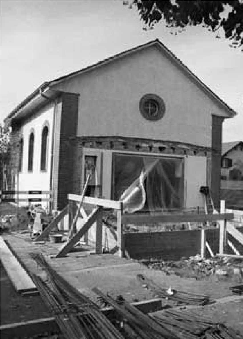
Die Sanierungsarbeiten an der Kapelle und am Betriebsgebäude auf dem Riehener Friedhof sind derzeit in vollem Gange. Für die umfassende Renovation hatte der Einwohnerrat im Februar dieses Jahres einen Kredit von insgesamt 2,31 Mio. Franken bewilligt.
