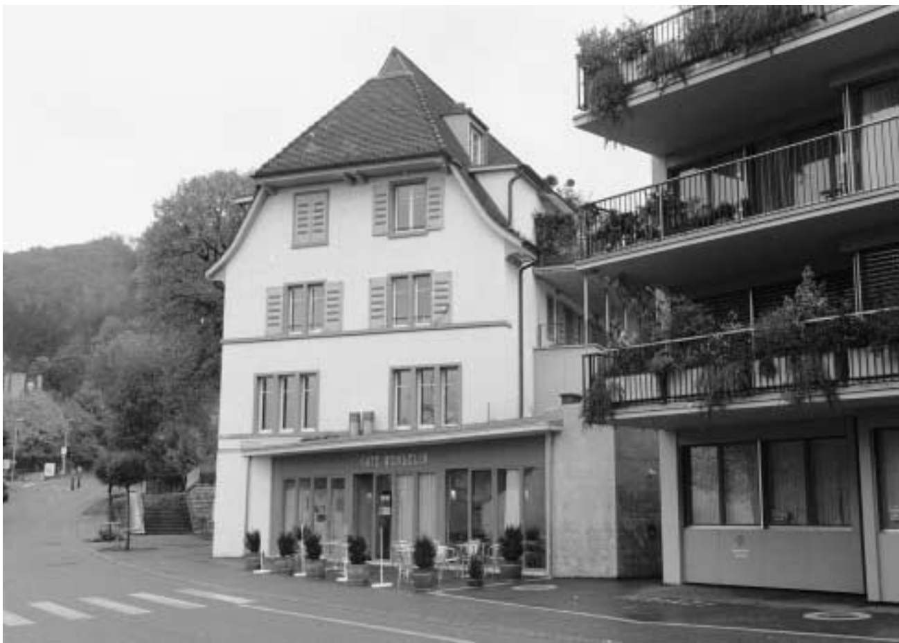
Mit grossen Abschreibungen ist für die «Problemliegenschaft» Hauptstrasse 88, wo Polizeiposten, das Café «Wendelin» und Wohnungen untergebracht sind, eine Wertberichtigung vorgenommen worden.
