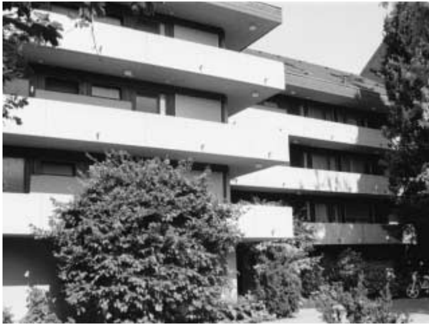
Die Fenstersanierung wird das Erscheinungsbild der Alterssiedlung «Drei Brunnen» nicht verändern. Nach Abwägen aller Vor- und Nachteile hat der Gemeinderat die Variante von verglasten Balkonen wieder fallen gelassen. Foto: RZ-Archiv
