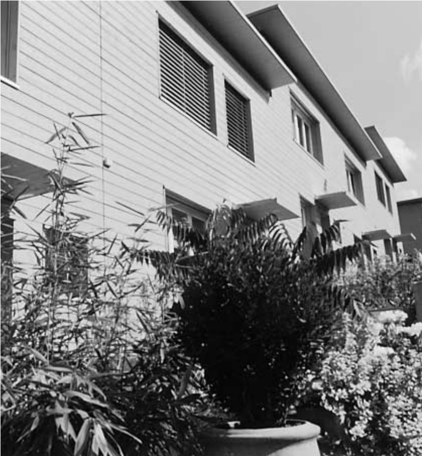
Gut erkennbar ist auf dieser Foto die Holzkonstruktion der Fassaden in so genannter Brettstapel-Bauweise. Fotos: zVg
