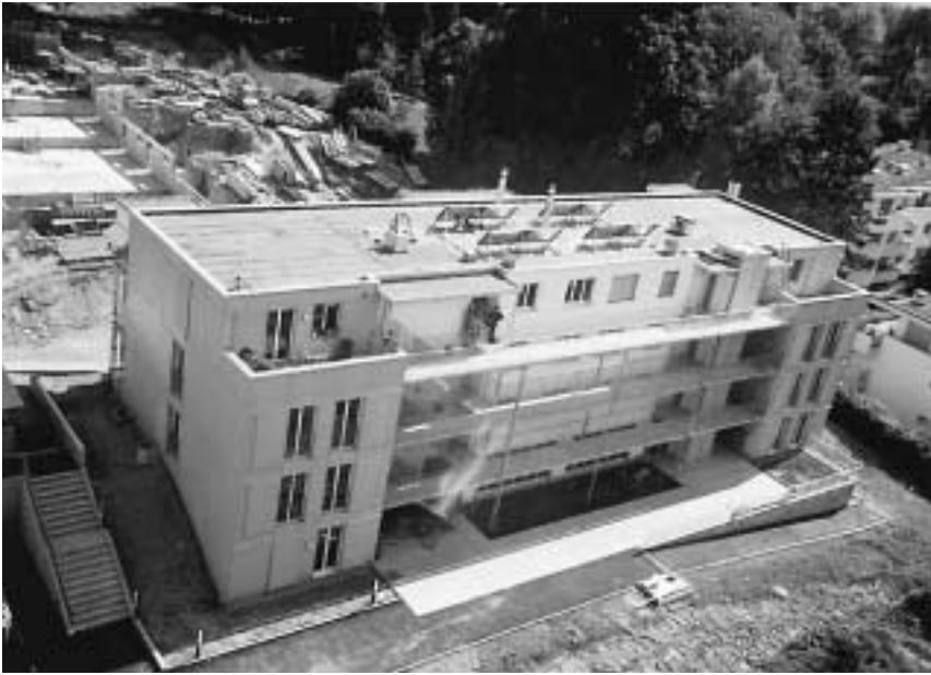
Blick vom Baukran aus auf das Mehrfamilienhaus. Foto: zVg
