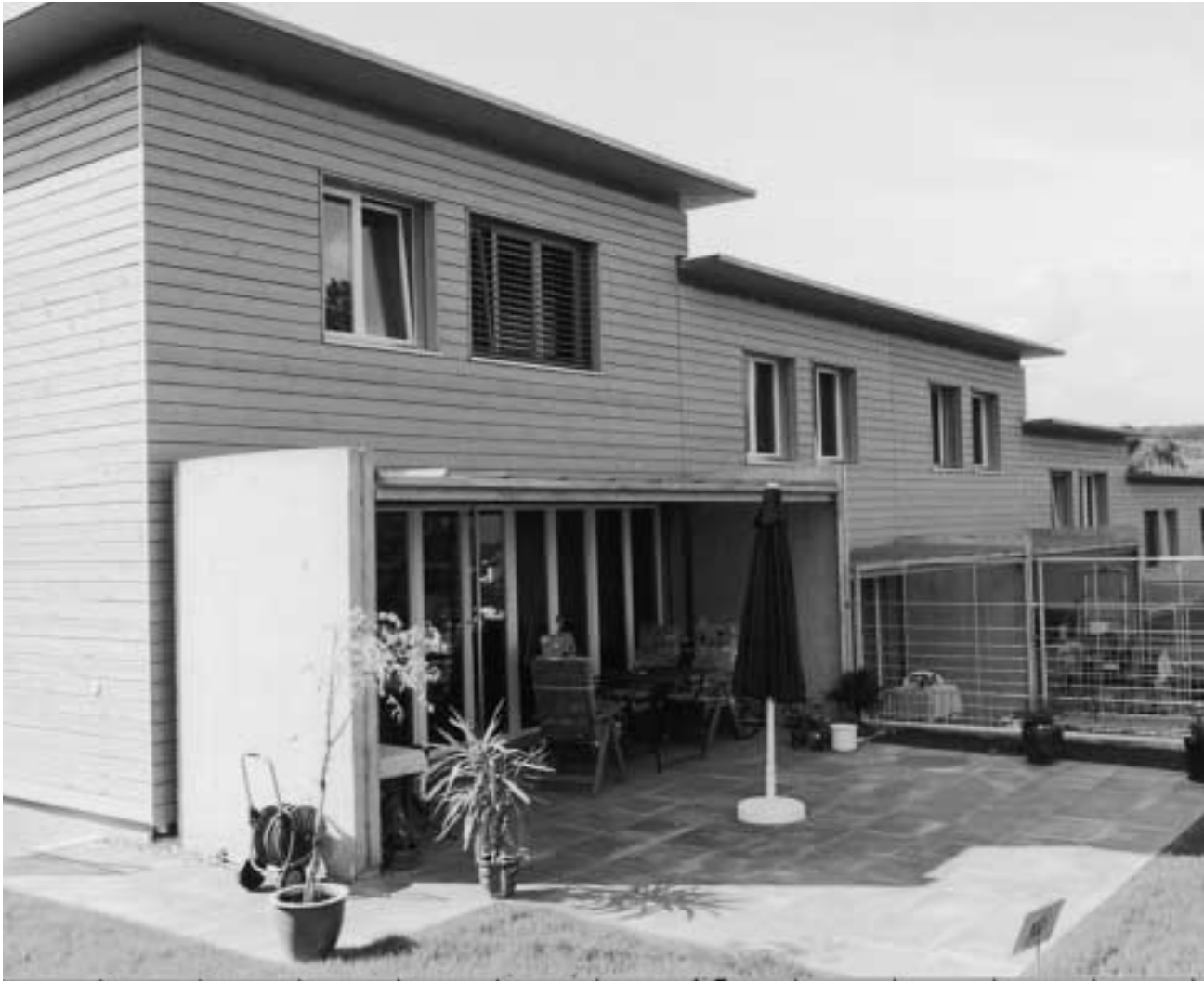
Der jedem Haus zugeordnete Aussenbereich ermöglicht eine individuelle Gestaltung des Gartens nach den persönlichen Vorlieben der Eigentümerinnen und Eigentümer. Foto: zVg
