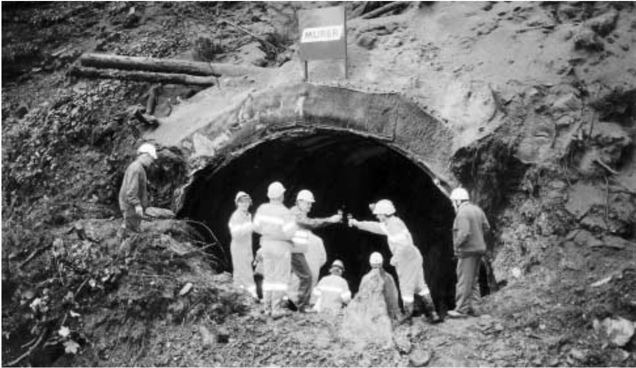
Mineure stossen auf den erfolgten Tunneldurchstich an. Anders als üblich wurde der Tunnel nicht von zwei Seiten her, sondern direkt von innen her geöffnet. Fotos: Erwin Wyss
