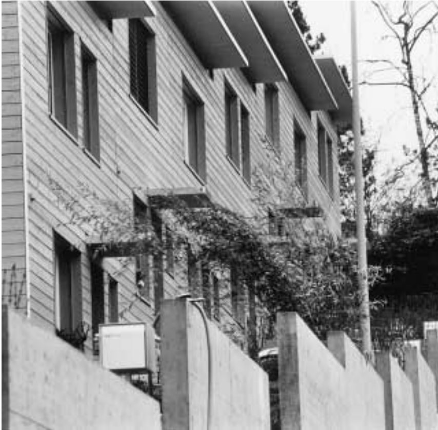
Die geländebezogene Architektur der Wohnüberbauung Gehrhalde bietet immer wieder faszinierende Perspektiven.
