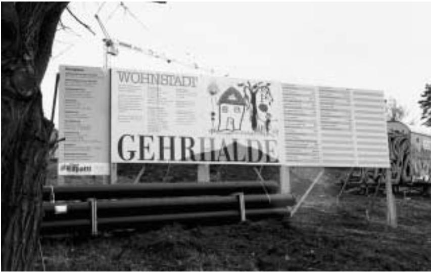
Im Januar vergangenen Jahres begannen an der Gehrhalde die Bauarbeiten. Signalisiert wurde der Baubeginn mit dieser Tafel.
