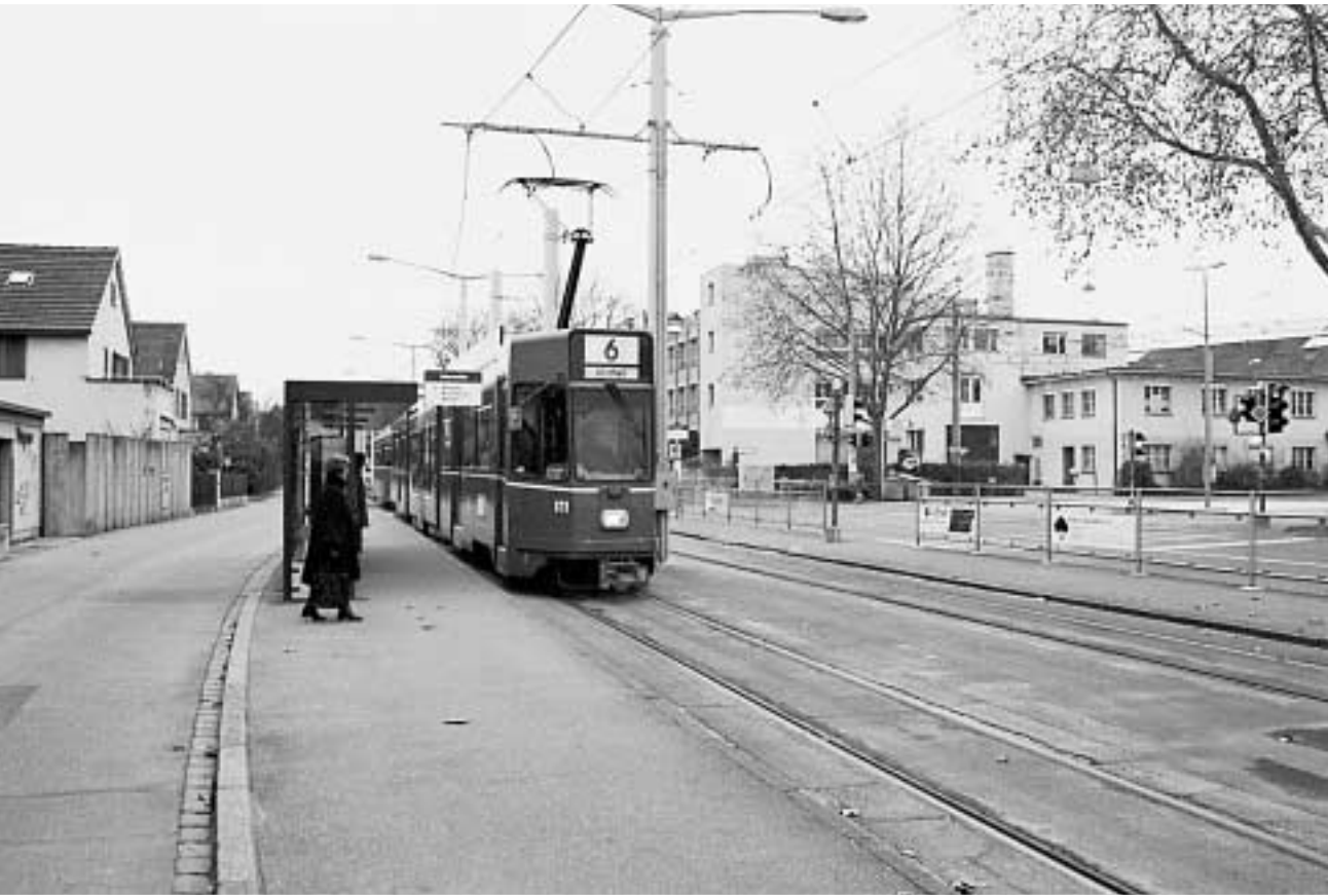
Mit einer Sedum-Begrünung des Tramtrassees soll die Lärmbelastung für die Anwohnerschaft der Riehener Hauptverkehrsachse zwischen den Haltestellen Niederholz und Habermatten (Bild) deutlich reduziert werden. Foto: RZ-Archiv
