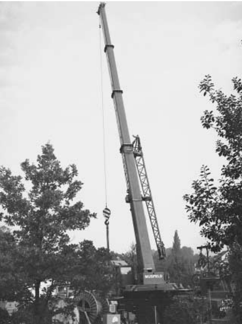
An der Geothermieberbohrstelle am Bachtelenweg wird derzeit mittels eines Pneumokrans eine Pumpe ausgewechselt.
