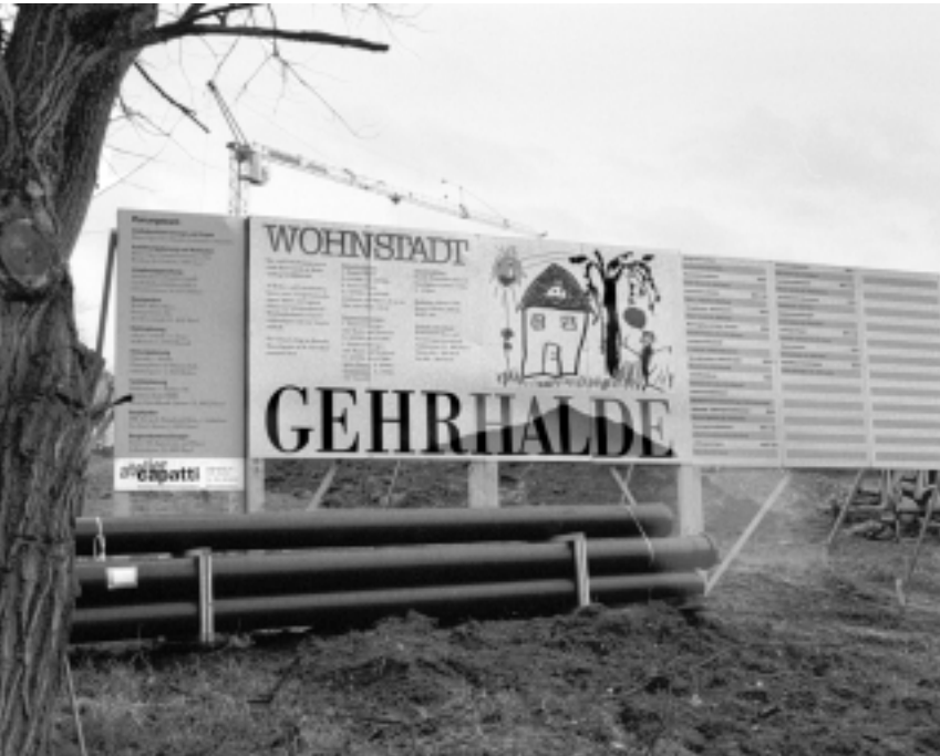
Im Gebiet Gehrhalde, wo die Bauarbeiten bereits im Gang sind, kommt eine der beiden bewilligten Strassenbeleuchtungsanlagen zu stehen. Foto: Rolf Spriessler
