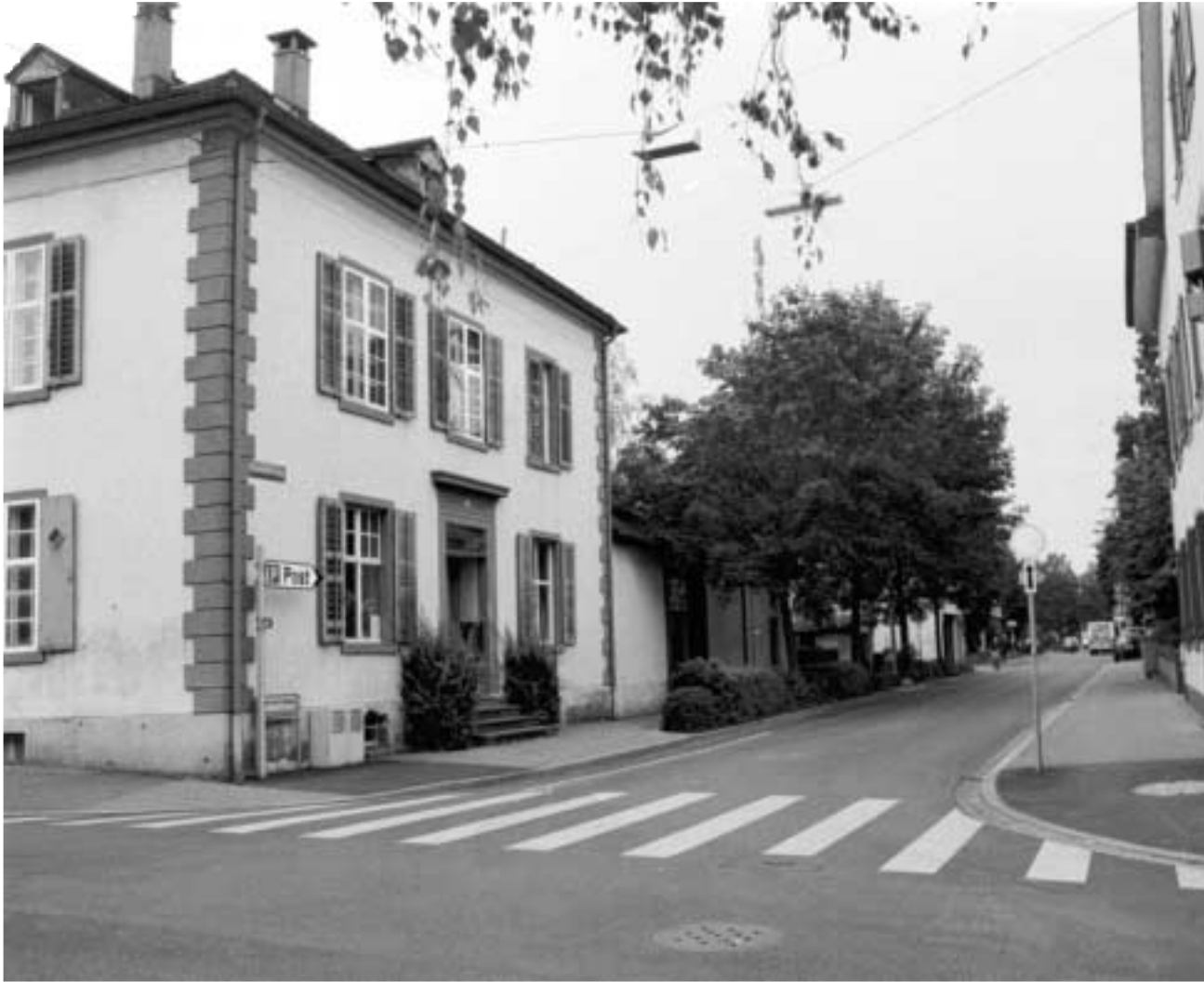
Blick von der Schmiedgasse in die Bahnhofstrasse: Das an das Haus Nr 3 (eingeschossiges Gebäude) anschliessende Areal soll gemäss Antrag des Regierungsrates in die Schonzone zu liegen kommen.
