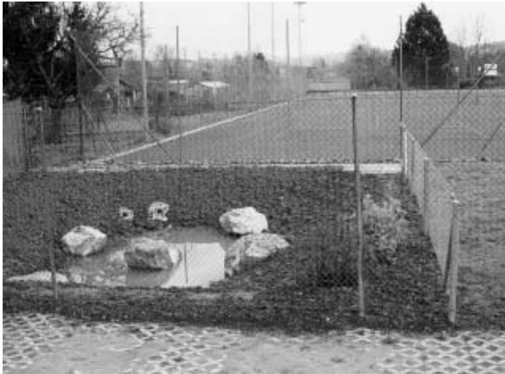
Die Sickergrube zur besseren Platzentwässerung ist das auffälligste Element der soeben abgeschlossenen Renovation des Tennisplatzes Stettenfeld. Foto: zVg
