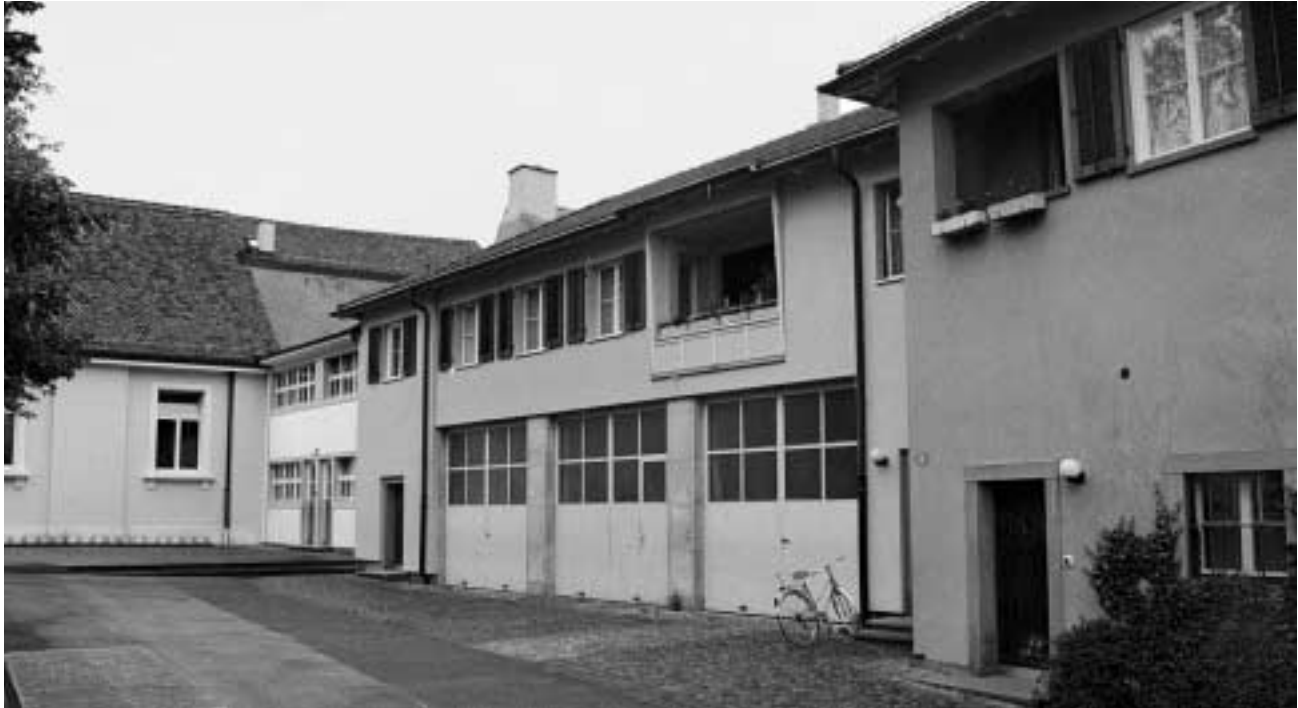
In diesem Gebäudeteil, der zum Schulhof des Erlensträsschenschulhauses (links im Bild) zeigt, einst als Feuerwehrmagazin diente und im Moment noch von einem Kleinunternehmer genutzt wird, soll der neue Sicherheitstrakt entstehen.
