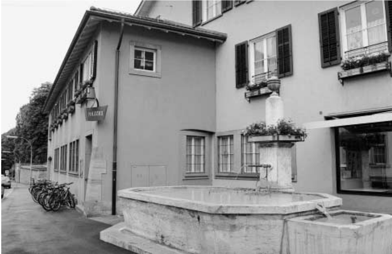
Die Polizeiwache Riehen heute: links, unter dem stilisierten Polizeihut, – der heutige Haupteingang, hinter dem Brunnen ist links jenes Fenster zu sehen, an dessen Stelle die neue Eingangstüre eingebaut werden soll.
