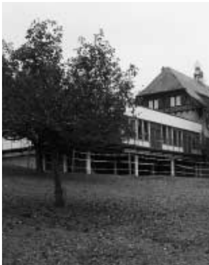
Auf dem Areal des Schulheims «Zur Hoffnung» steigt ein Fest mit Spatenstich für den Neubau.
