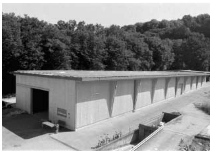
Die neue Fahrzeughalle auf dem Werkhof des Friedhofs Hörnli, auf deren Dach sich eine grosse Solarstromanlage befindet.
