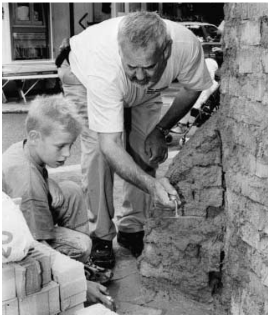
Unter kundiger Anleitung von Bauunternehmer Theo Seckinger lernte dieser kleine Handwerker, wie man eine tadellos verarbeitete Mauer hochziehen kann.
