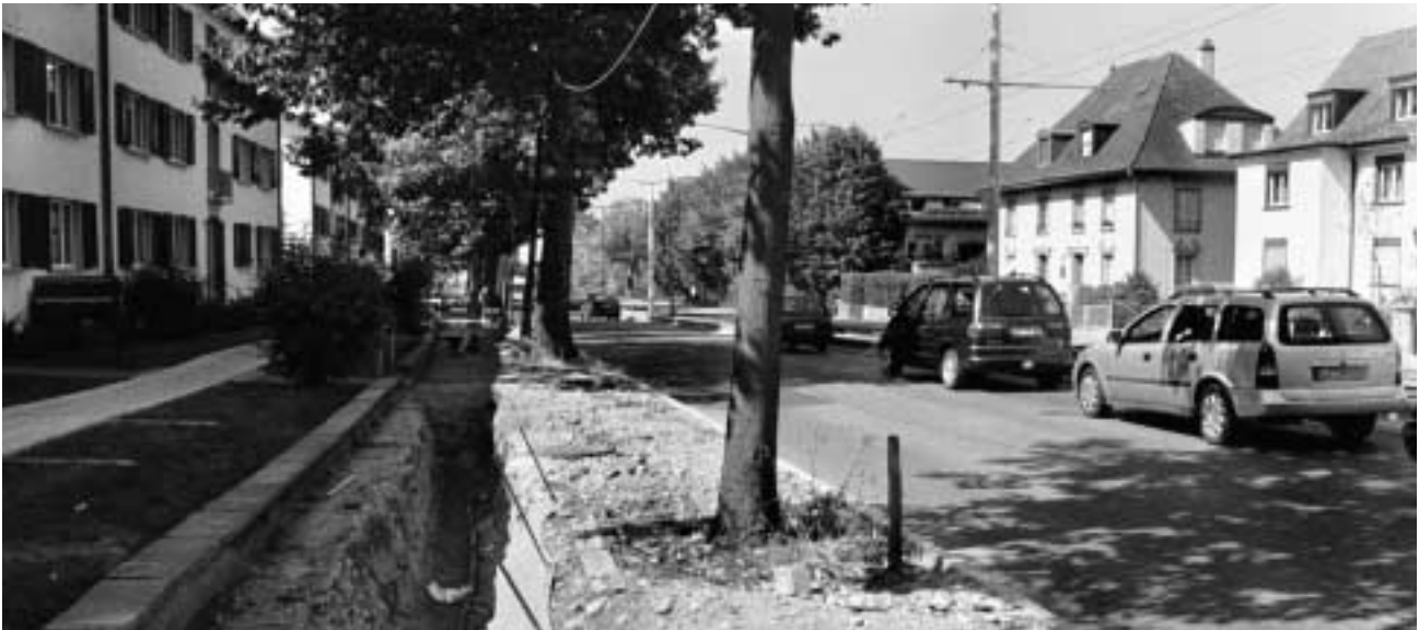
Mit dem Einbringen des Deckbelages geht die langwierige Bauzeit an der Aeusseren Baselstrasse – hier ein Bild von Ende Juni dieses Jahres – zu Ende. Danach soll der Verkehr endlich wieder ohne Behinderungen und Staus rollen. Foto: RZ-Archiv
