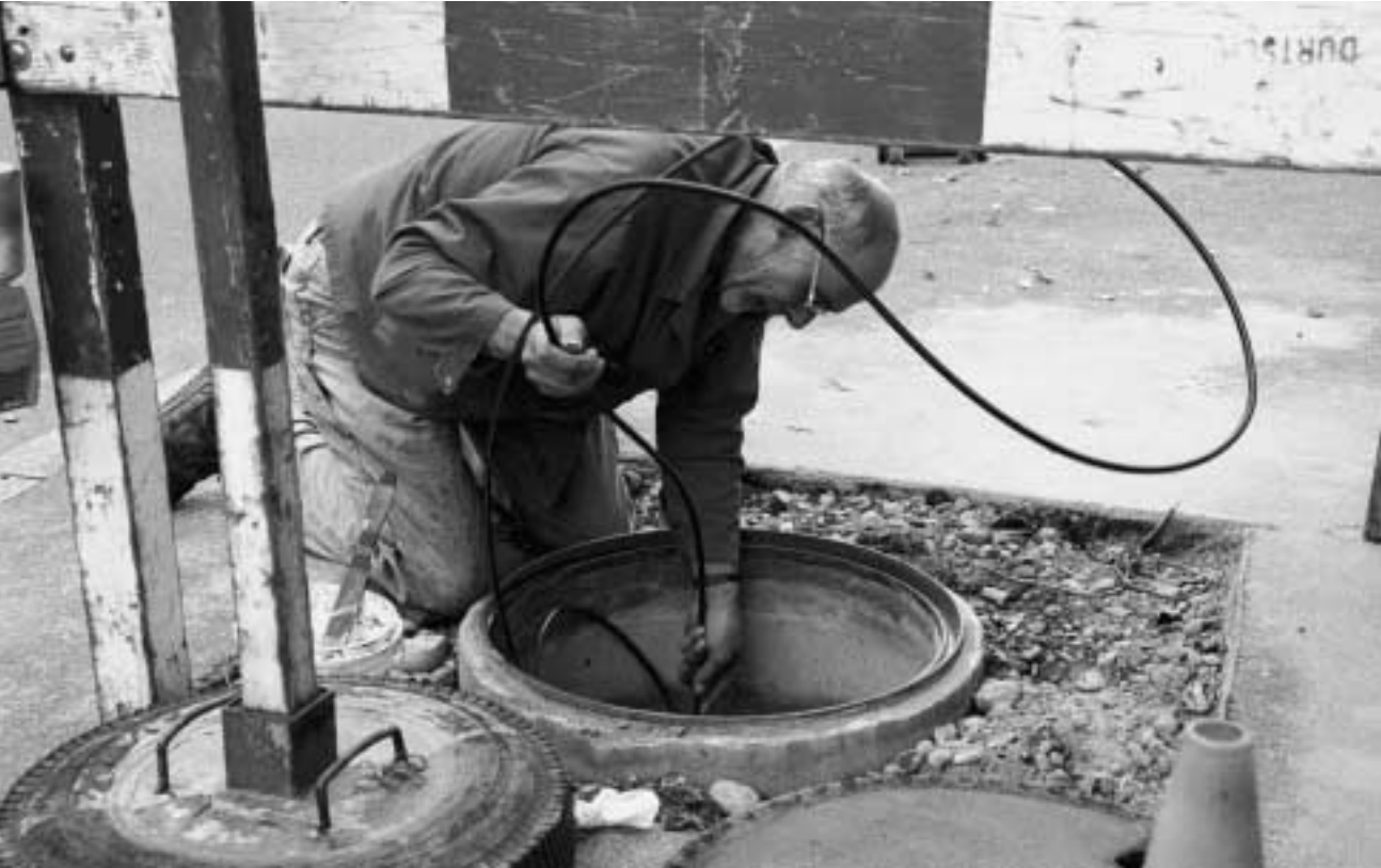
Mit Kosten von 2,5 Mio. Franken ist der Ausbau des neuen Kommunikationsnetzes (K-Netz) – unser Bild zeigt das Verlegen des Glasfaserkabel – das grösste Investitionsvorhaben im kommenden Jahr.
