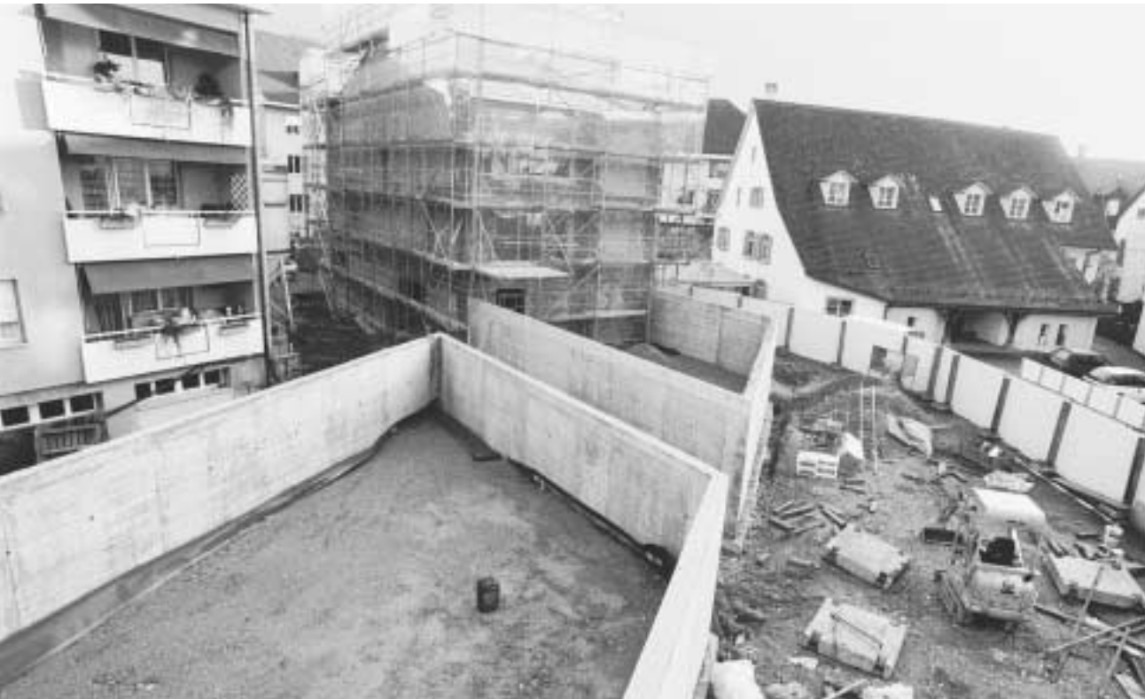
Blick auf die Baustelle im Singeisenhof, fotografiert vom Neubau an der Gartengasse mit Blick zum Neubau an der Rössligasse, rechts hinten ist das Schweizerhaus, links ein Teil des Wohnhauses Rössligasse 33/35 zu sehen. Foto: Philippe Jaquet
