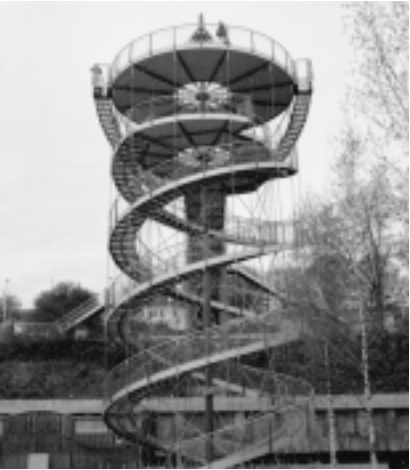
Der «Schlaichturm» verbindet die «Grün 99» mit dem neuen Haltepunkt «Gartenstadt» der Regio-S-Bahn.
