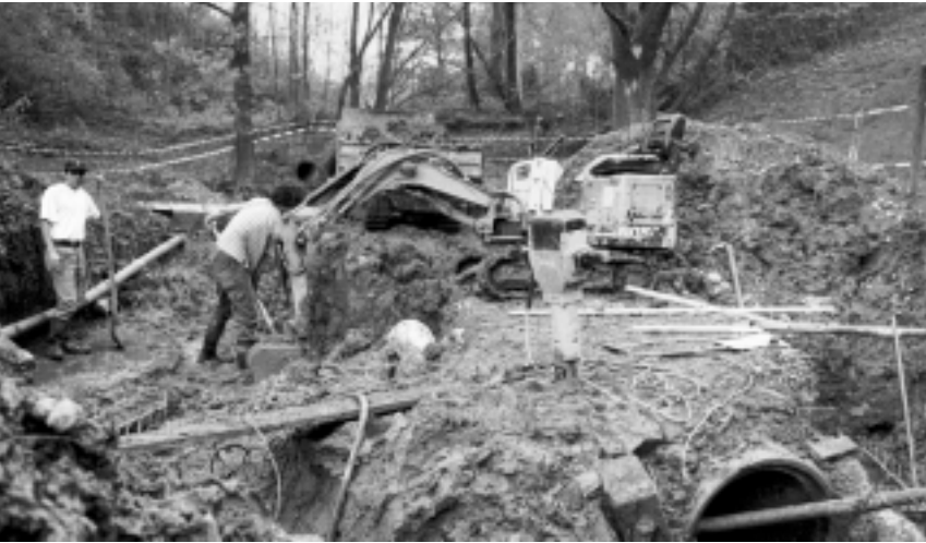
Beispiel eines aus dem Sozialstellenplan finanzierten Einsatzes 1996: Eine Gruppe der Institution «Overall» bei Bachsanierungsarbeiten. Foto: RZ-Arciv
