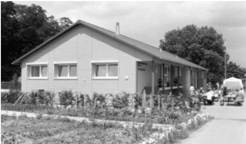
Das neue Clubhaus – Mittel- und Treffpunkt der neuerstellten Familiengärten «In den Weilmatten». Foto: Amos Winteler
