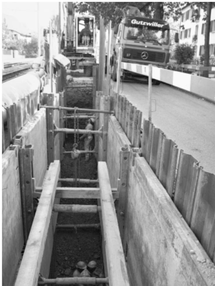
Heikle Situation – während die Bauarbeiter in einigen Metern Tiefe die neuen Kanalisationsrohre verlegen, rollt wenige Zentimeter daneben der Verkehr. Die Platzverhältnisse entlang der Baustelle sind momentan so eng, dass fast jeden Tag Teile der Bauabschränkung in die Baugrube fallen. Fotos: Dieter Wüthrich
