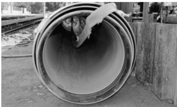
Die Skizze des Strassenquerschnittes (oben) illustriert eindrücklich die ausserordentlich engen Verkehrsverhältnisse im Bereich der Baustelle. Aus Gründen des Gewässerschutzes muss die neue Kanalisation im Doppelwandrohr-Verfahren erstellt werden (Bild unten).
