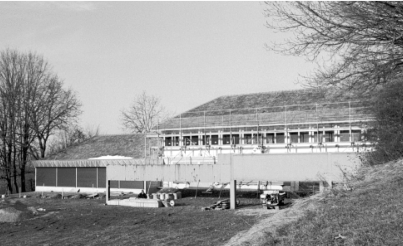
650'000 Franken sind im Voranschlag 2000 für die Sanierung des Riehener Schiessstandes eingestellt.
