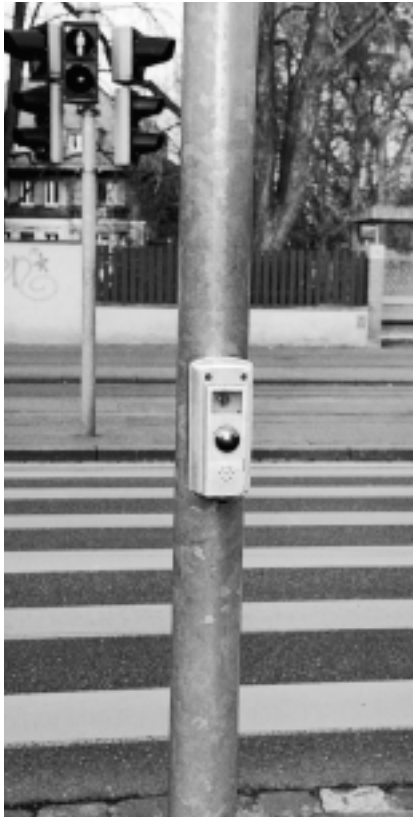
Beispiel für eine Ampelanlage, die über Knöpfe mit akkustischem Signal und Vibrator verfügt.
