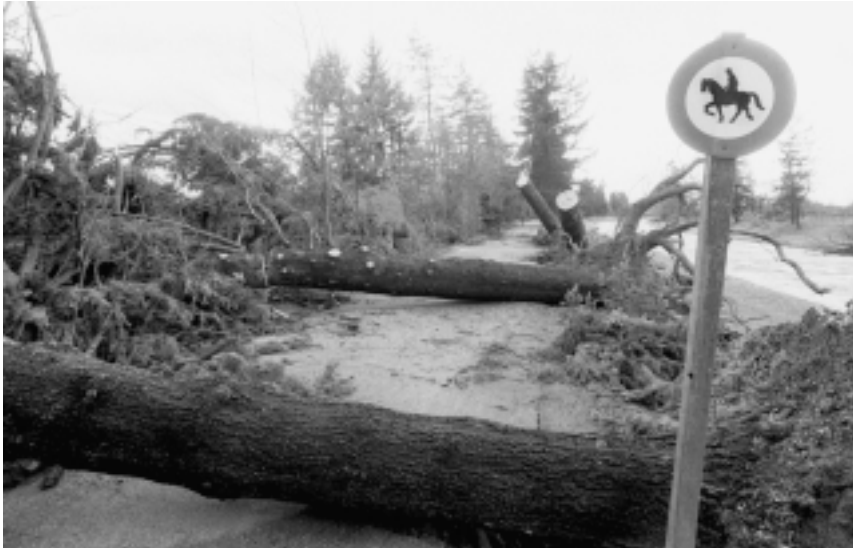
Nicht nur für Reiter kein Durchkommen mehr: An der Uferböschung der Wiese hinterliess der Sturm eine breite Spur der Verwüstung.
