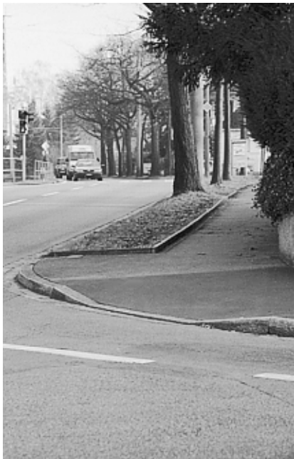
Trottoirabsenkungen sind sowohl für Rollstuhlfahrer als auch für Sehbehinderte geeignete Lösungen.
