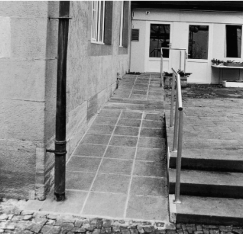
Mit dieser Rampe vom Kilchgässli her und dem Einbau eines Personenliftes wurde der Landgasthof, der auch über ein Rollstuhl-WC verfügt, rollstuhlgängig gemacht.
