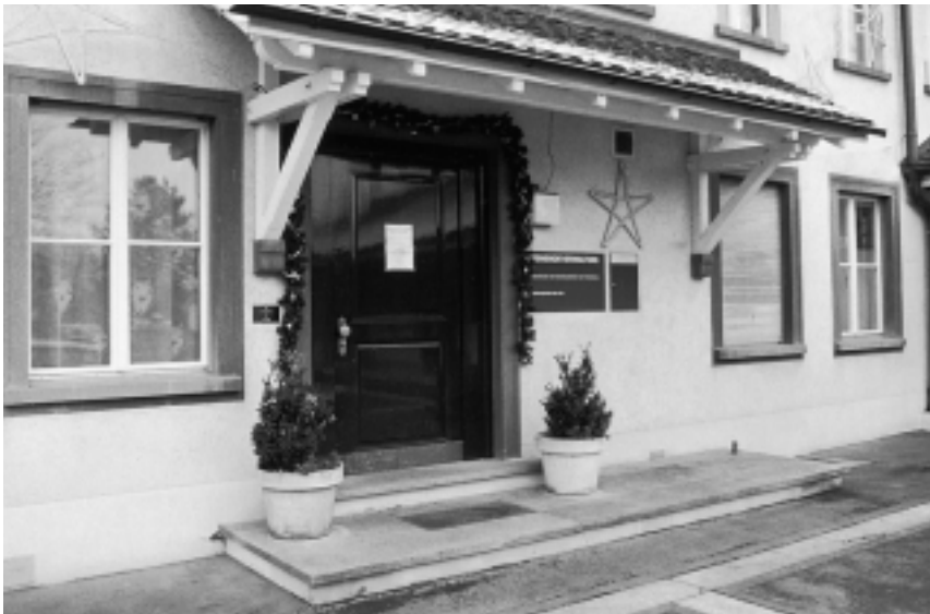
Der Eingang zum Bettinger Gemeindehaus: Würde man den oberen Tritt zu einem grösseren Plateau nach vorne ziehen, könnte man links eine Rampe einbauen und das Haus wäre im Rollstuhl zugänglich.
