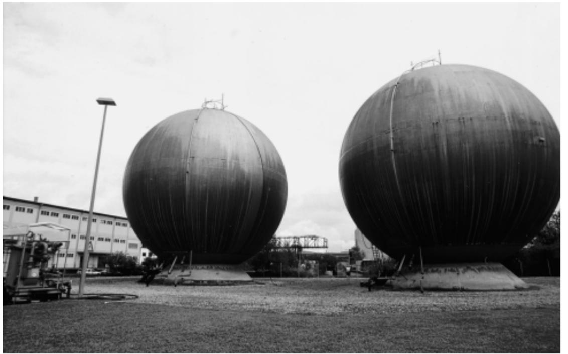
Dank höchstem Wirkungsgrad und schadstoffarmer Verbrennung ist Erdgas ein umweltschonender Energieträger. Unser Bild zeigt die Kugelspeicherbehälter für den Tagesbezugsausgleich auf dem IWB-Areal Kleinhüningen.
