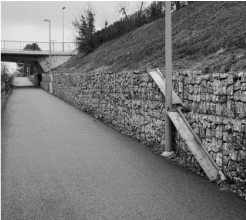
Versuch am Veloweg an der Wiesentalbahn: mit Holzrampen soll den Amphibien die Wanderung Richtung Morystrasse ermöglicht werden.
