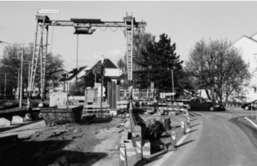
Sattsam mit Baulärm, Staub und Umtrieben versorgt ist das Niederholzquartier: nebst den nun beschlossenen Kanalisations- und Strassensanierungen wird die Baustelle an der Aeusseren Baselstrasse zwischen Habermatten und Kilchgrundstrasse (im Bild) bis nach der Jahrtausendwende bestehen bleiben.
