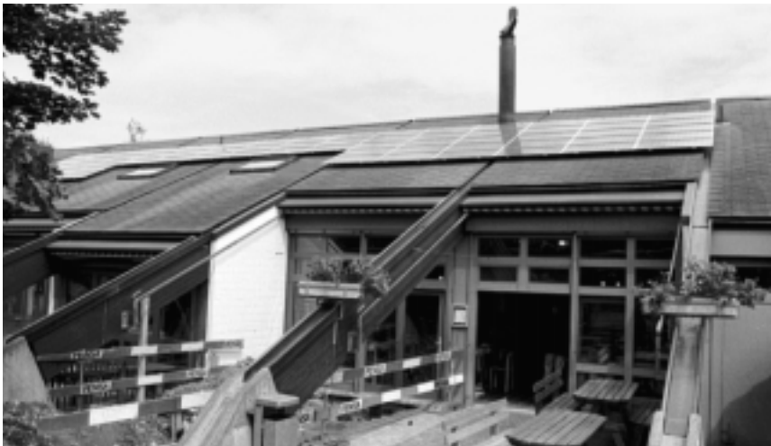
Die neue Photovoltaik-Anlage auf dem Dach des Freizeitzentrums Landauer soll jährlich rund 6200 Kilowattstunden Strom produzieren.
