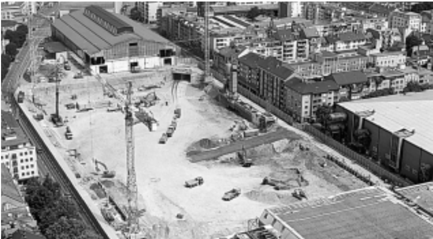
Beeindruckende Masse: 20'000 Quadratmeter gross und 6 Meter tief ist die Baugrube bei der Messe Basel.
