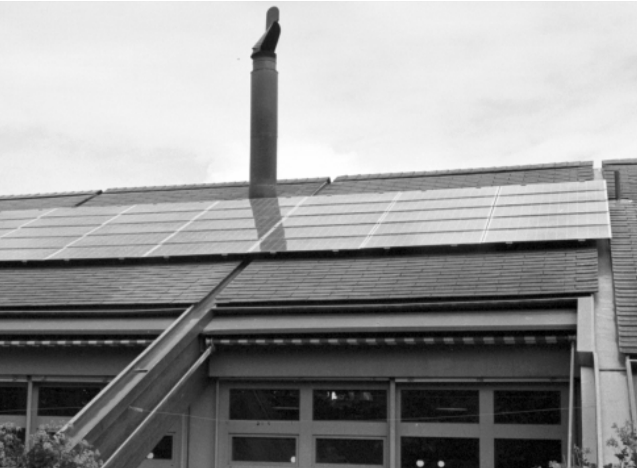
Photovoltaikanlagen – hier diejenige, die vor kurzem auf dem Dach des Freizeitentrums Landauer in Betrieb genommen worden ist – sind nur eine von vielen Möglichkeiten, dezentral sinnvoll Energie zu produzieren.
