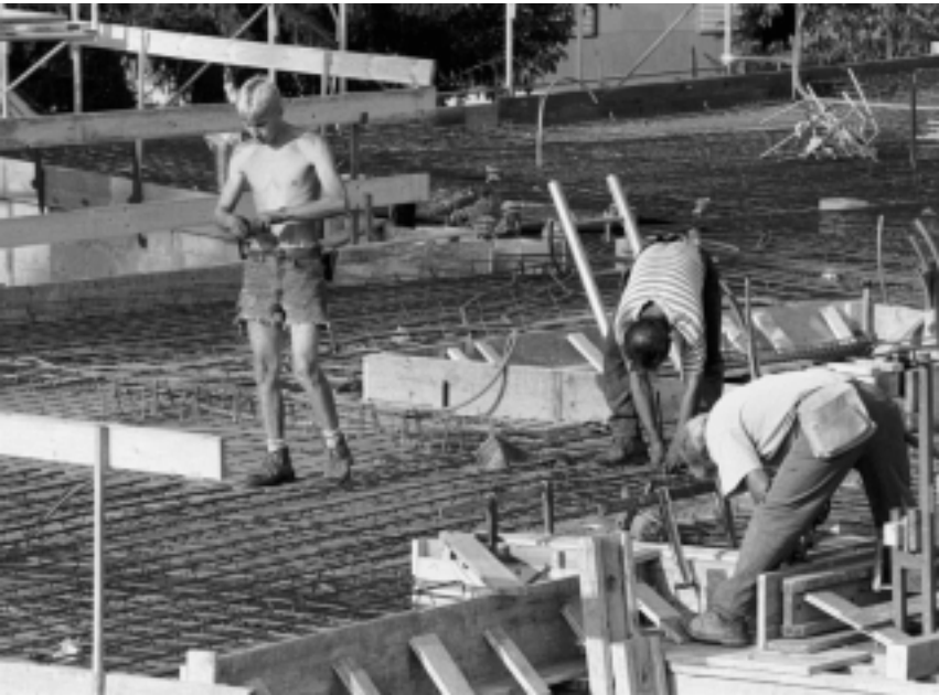
...gönnten sich die Eisenleger auf der benachbarten Stagrimus-Baustelle keine Ruhepause. Bald soll auch dort Aufrichte gefeiert werden. Fotos: Philippe Jaquet
