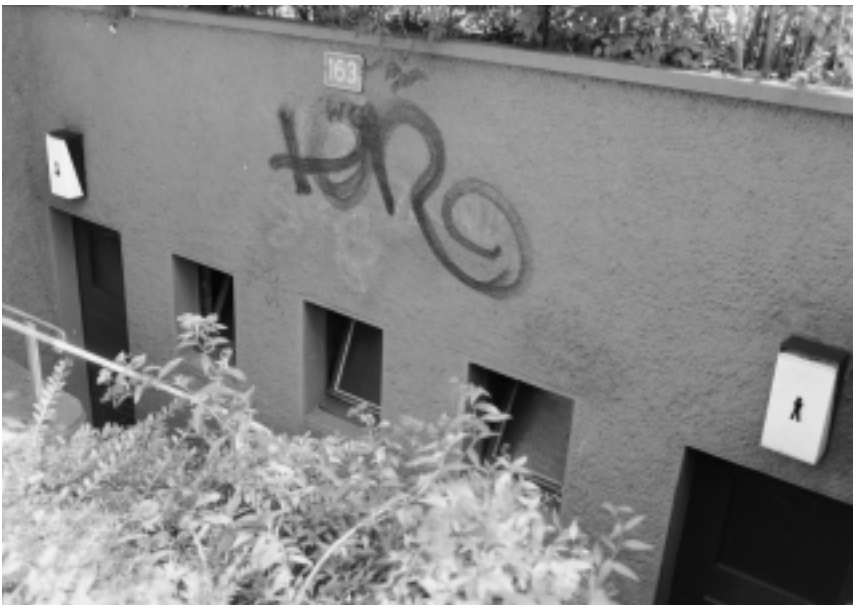
Die öffentliche WC-Anlage bei der Tramhaltestelle Burgstrasse ist veraltet und wird nun geschlossen, um zu sehen, ob sie tatsächlich einem Bedürfnis der Bevölkerung entsprechen würde.
