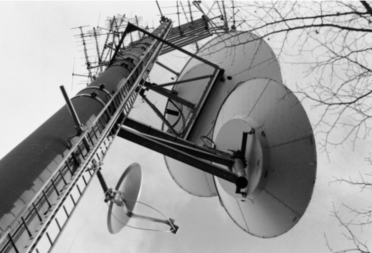
Mit der Umrüstung von Kupferkabel- auf Glasfasertechnik kann nicht nur das TV- und Radio-Programmangebot der Gemeinschaftsantennen-Anlage (Bild) wesentlich ausgebaut, sondern es können auch neue Technologien wie Internet genutzt werden. Bis in einem Jahr sollen mindestens 60 Prozent der Haushalte angeschlossen sein. Foto: Philippe Jaquet
