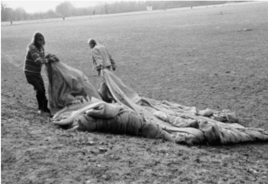
...und anschliessend zusammengefalt und zum Recycling abtransportiert. In Zukunft soll das Gewebe als Unterlage von Filzmatten dienen.
