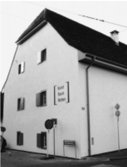
Das neue Ausstellungsgebäude der Gemeinde wurde Ende März eröffnet.
