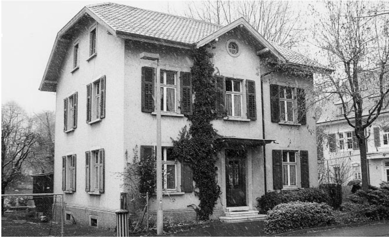
Über die Frage, wer in Zukunft für das Rieherer Fürsorgewesen (unser Bild zeigt das Fürsorgeamt an der Bannhofstrasse 34) zuständig sein soll – ob wie bisher die Bürgergemeinde, die Einwohnergemeinde oder allenfalls eine dritte Variante – soll das sich in Erarbeitung befindende Sozialleitbild der Gemeinde Riehen Klarheit schaffen. Foto: RZ-Archiv
