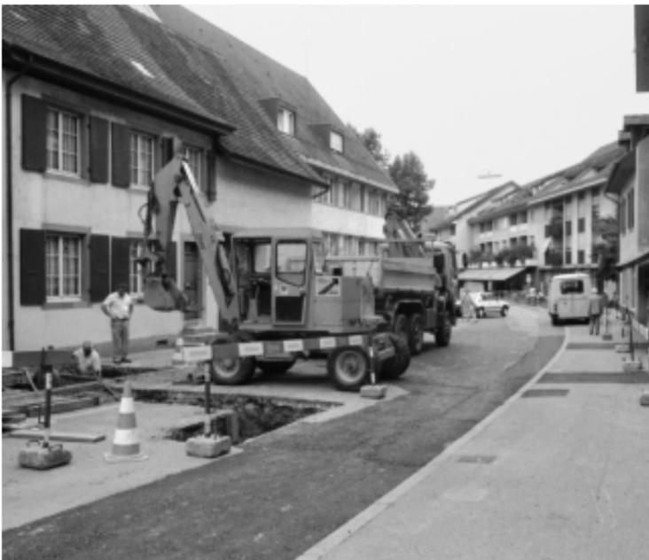
Die vom Gemeinderat beantragte Wärmeverbund-Ringleitung durch die Schmiedgasse würde grössere Tiefbauarbeiten notwendig machen, wie sie bereits im Jahre 1989 (unser Bild) – ebenfalls im Zusammenhang mit dem Wärmeverbund – durchgeführt werden mussten.
