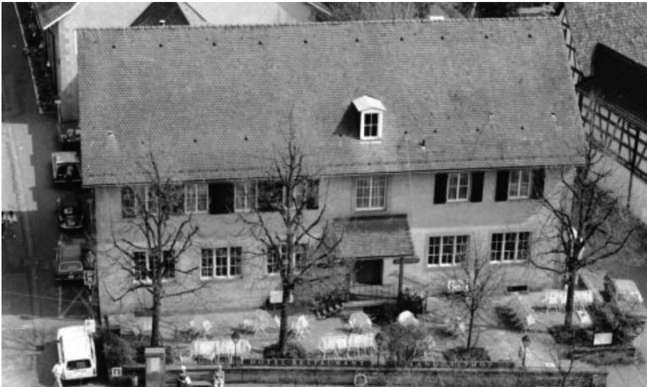
Wenig komfortable Oase in der Riehener Hotellerie-Wüste: mit dem Einbau von zusätzlichen Nasszellen soll der Standard im Restaurant «Landgasthof» bis zur Jahrtausendwende (unser Bild) verbessert werden. Foto: RZ-Archiv
