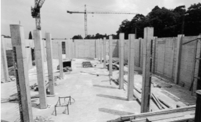
1995/1996: Aus einer Grossbaustelle erhebt sich nach und nach das Museum – hier das Erdgeschoss mit den Ausstellungsräumen.
