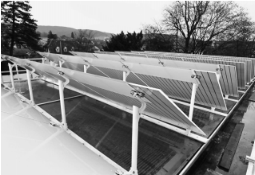
1996/97: Als eine der grössten technischen Herausforderungen des ganzen Baus wird nach und nach die filigrane Konstruktion des Glasdaches mit den «Sonnen-segeln» erstellt.
