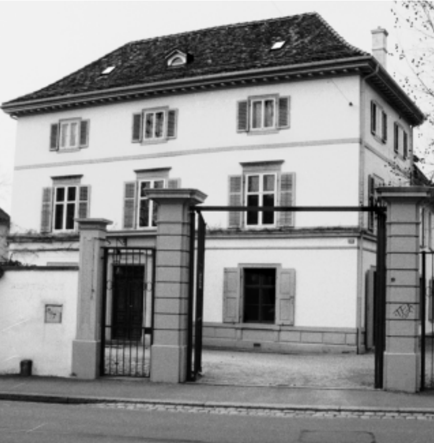
Die Sanierung der Berower-Villa – hier während des Umbaus im vergangenen Jahr – hat für unliebsame und teure Überraschungen gesorgt. Foto: RZ-Archiv
