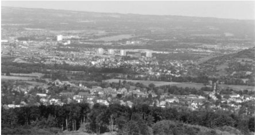
Durch das Nein der Schweiz zur EU ist auch die Entwicklung des Kommunikationsraumes Basel über die Landesgrenzen hinaus – hier der Blick vom Fernmeldeturm St. Chrischona Richtung Elsass und Südbaden – blockiert.
