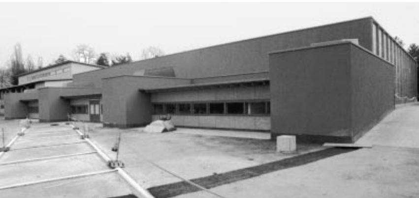
Die Bauarbeiten an der Dreifachturnhalle Niederholz gehen zu Ende, und schon bald werden hier die Riehener Sportlerinnen und Sportler der schönsten Nebensache der Welt frönen können. Foto: Philippe Jaquet
