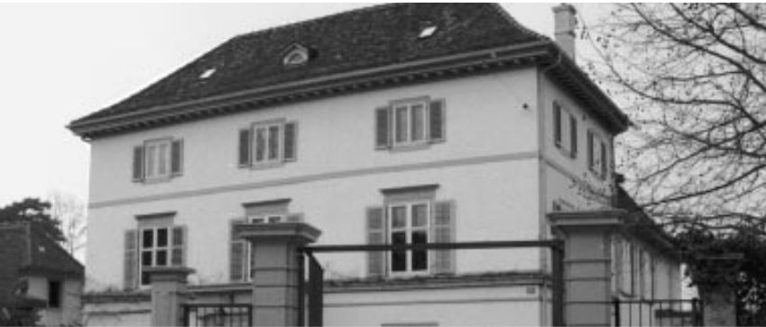
Schäden festgestellt: Herrschaftshaus des Berower-Gutes Foto: RZ-Archiv
