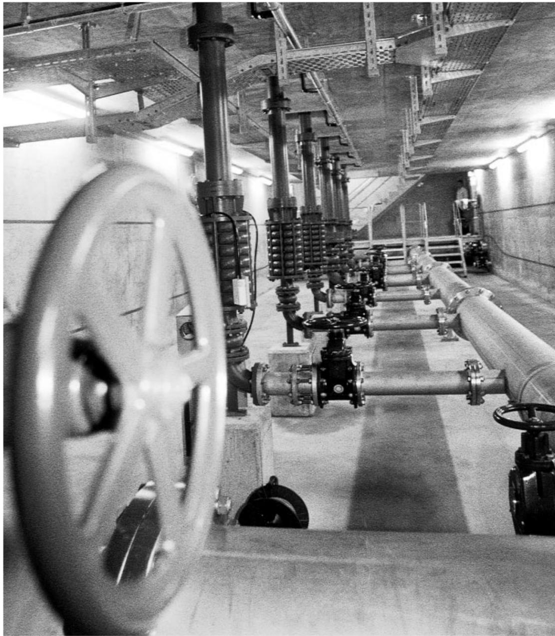
Das Pumpwerk im zweiten Untergeschoss. Von hier aus wird das Trinkwasser in die höhergelegenen Regionen des Versorgungsgebietes transportiert.
