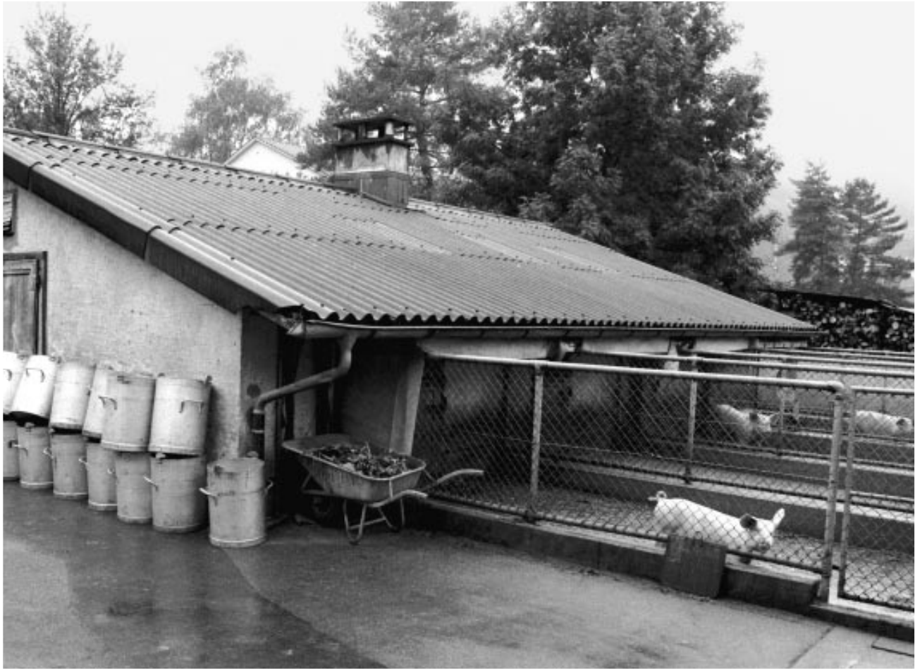
Der Schweinestall des Bettinger Dorfbauernhofes soll demnächst abgerissen werden und einem modernen Tretmiststall für Rinder und Jungvieh Platz machen.
